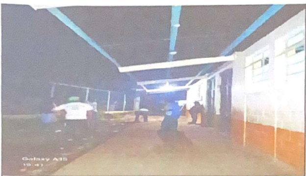
Foto 3: Cambio de techos
