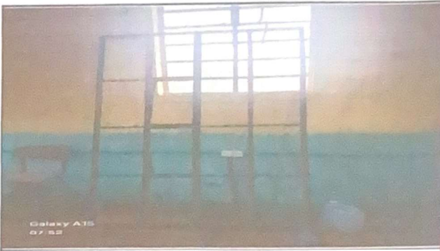
Foto 4: Instalación de ventanas de dos aulas.
