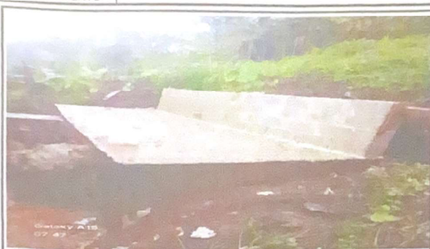
Foto 1: Reparación de plancha para tinacos.
