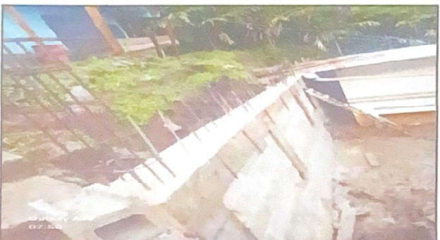
Foto 5: Mejoramiento de muro.
